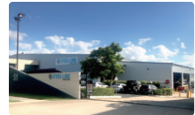
BX BUNKA AUSTRALIA PTY LTDの工場
