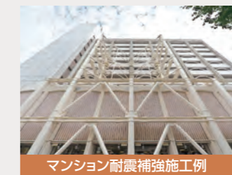
マンション耐震補強施工例
