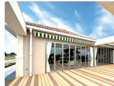
テクモクの施工例 養護老人保健施設 葵の園・八千代(茨城県)
