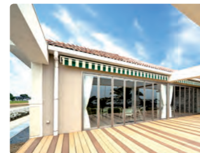
テクモクの施工例 養護老人保健施設 葵の園・八千代(茨城県)
