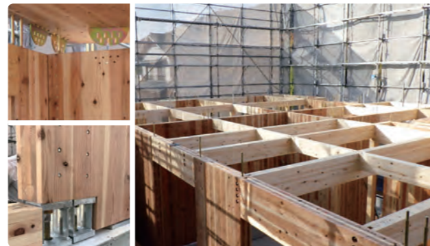
「LC-core構法」 施工現場
